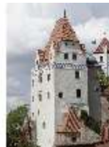
LaT.I, Wittelsbacher Turm von SW, DI022070, BSV
