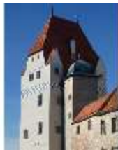
LaT.I, Wittelsbacher Turm von S, DI021280, BSV
