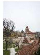
LaT.I, Gerichtsdienerrhaus mit Hungerturm, DI021352, BSV-
