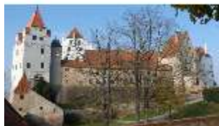
LaT.I, Burganlage mit Wittelsbacher Turm von S, DI021279, BSV
