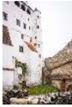
LaT.I, Söller mit Burgmauer, DI021355, BSV-
