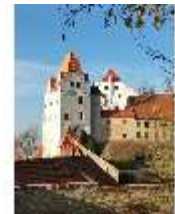
LaT.I, Burganlage mit Wittelsbacher Turm von S, DI021281, BSV
