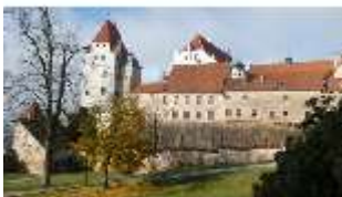
LaT.I, Burganlage mit Wittelsbacher Turm von S, DI021278, BSV
