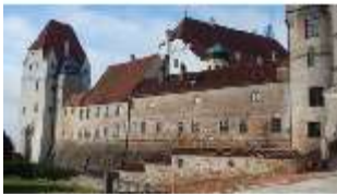
LaT.I, Hauptburg von Nordosten, DI021373, BSV-
