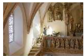
LaT.II, Burgkapelle St. Georg, Restaurationsarbeiten, DI014417, BSV-
