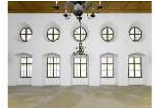
LaT.II, Weißer Saal, Fensterwand, DI000015, BSV
